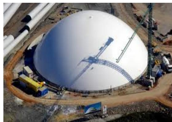
**2- Cúpulas laminares o cascarones.** La geometría de estas láminas ajusta las acciones gravitatorias a unos esfuerzos superficiales tridimensionales mayoritariamente de compresión. Con pequeños espesores se pueden soportar grandes acciones, siempre y cuando se encuentren bien repartidas.
