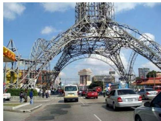
1- Ejemplos de estructuras trianguladas en donde los esfuerzos se reparten entre barras dispuestas en forma de triángulos. Las barras trabajan principalmente a tracción y compresión cosa que genera una gran ligereza y resistencia del conjunto.
